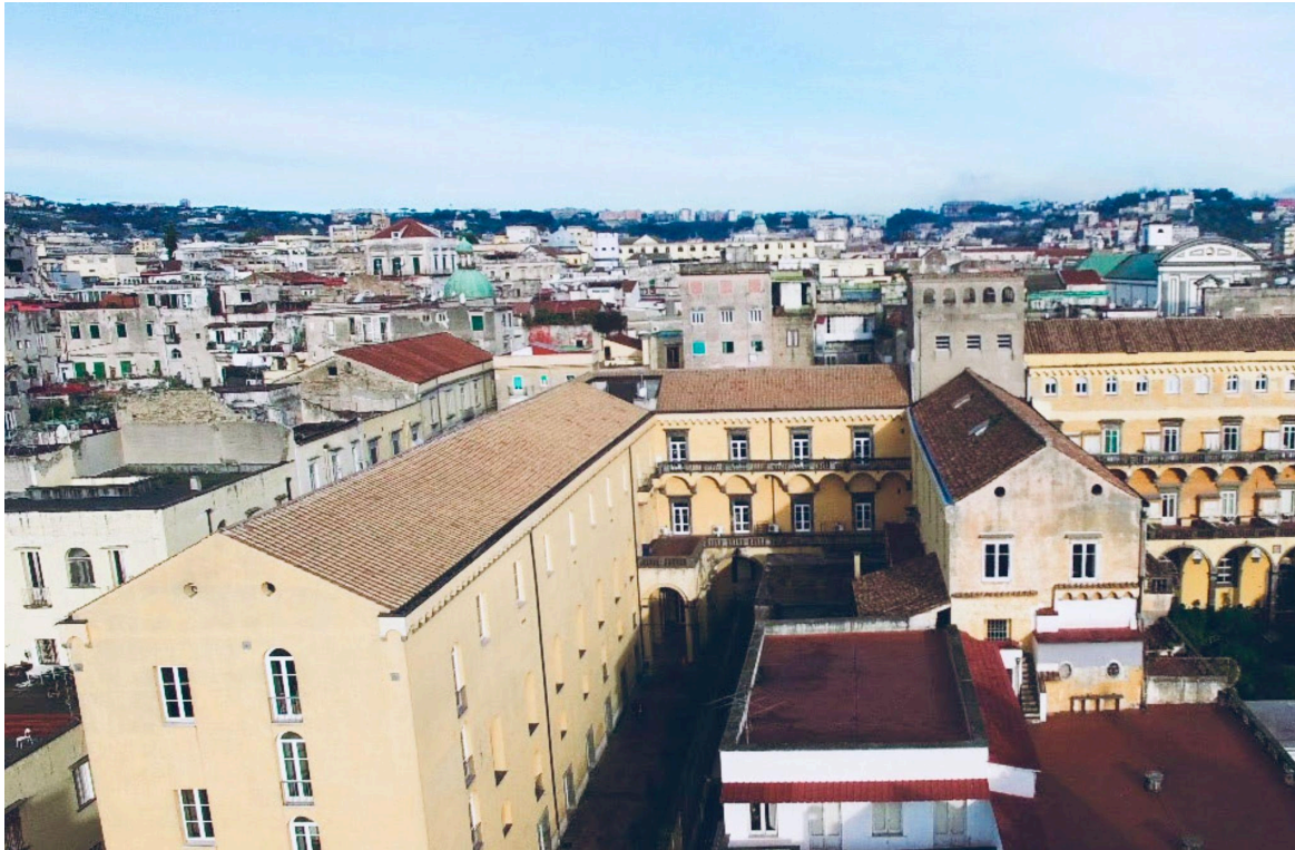
L'Asilo - Ex Asilo Filangieri, Naples, The Building
